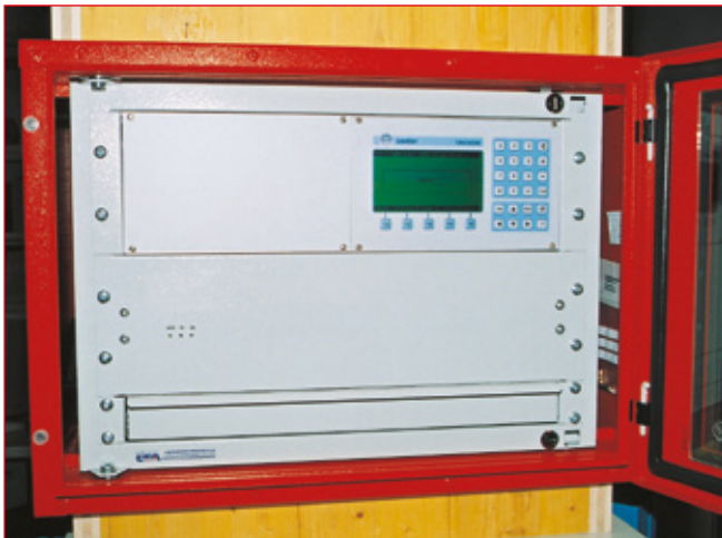
Sirenen-Steuereinrichtung der ersten Generation
