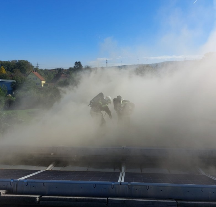
3 Wochen nach der Überflutung fängt Wechselrichter Feuer, Brand breitet sich über Installationsschacht auf den Dachstuhl aus
