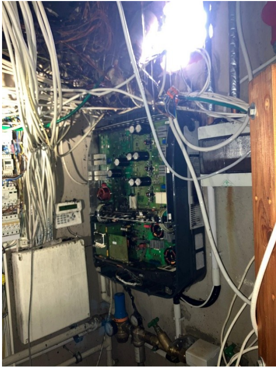
3 Wochen nach der Überflutung fängt Wechselrichter Feuer, Brand breitet sich über Installationsschacht auf den Dachstuhl aus
