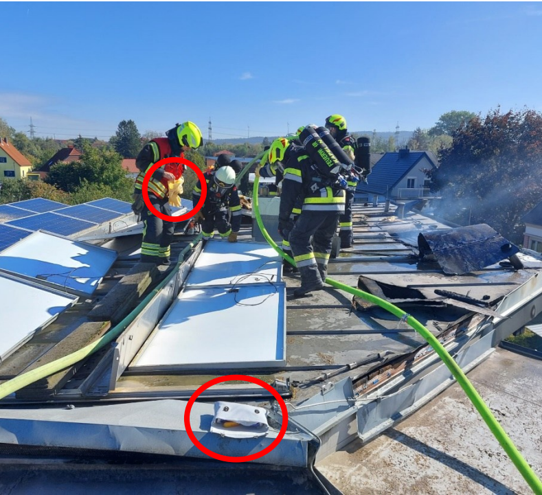
3 Wochen nach der Überflutung fängt Wechselrichter Feuer, Brand breitet sich über Installationsschacht auf den Dachstuhl aus
