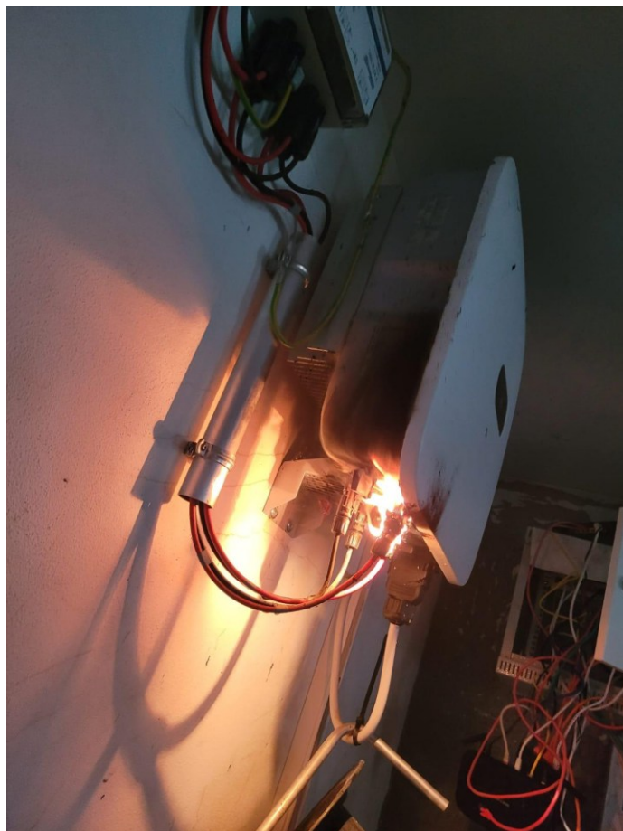
1 Woche nach der Überflutung fängt Wechselrichter Feuer
