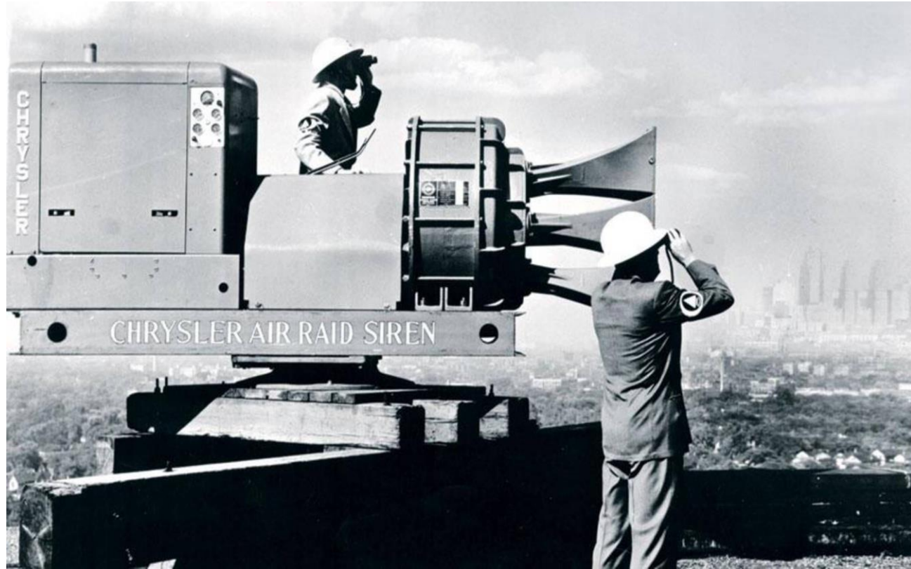
Air Raid Siren von ca. 1952, Lastwagenmotor V8, 180 PS!
