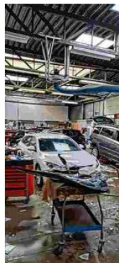
Dächer wurden zerstört.
