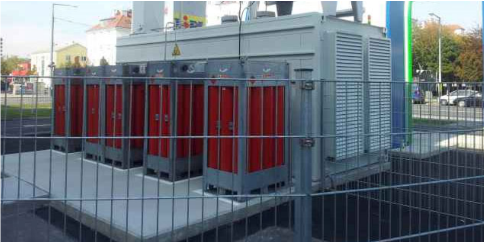
Abbildung 57: Rückseite Wasserstofftankstelle (Flaschenbündel) (Roman Sykora, ÖBFV)
