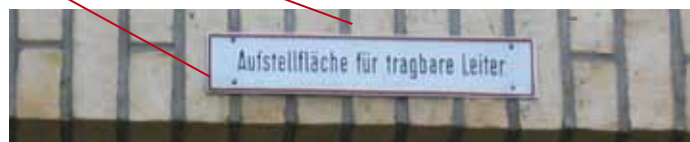
Ausgewiesene Aufstellfläche für eine tragbare Leiter
