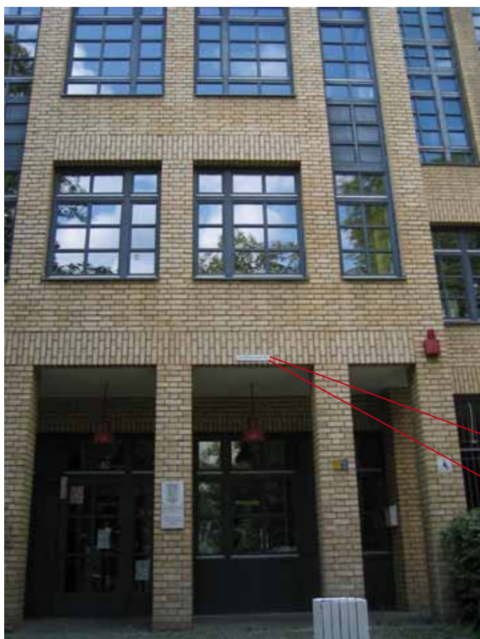
Ausgewiesene Aufstellfläche für eine tragbare Leiter
